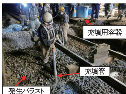
図 14 グラウト充填状況
