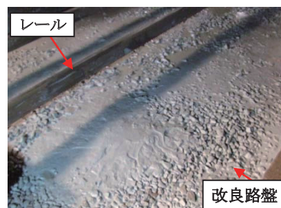
図 15 路盤改良層構築後
