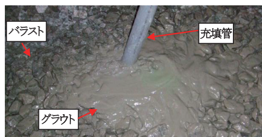
図1 グラウト充填工法の充填状況
