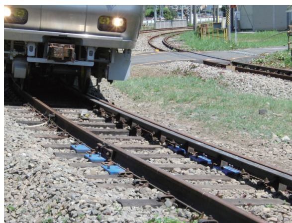
図 18 敷設後の状況
