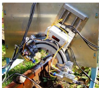
(c) ゲージコーナーの測定(30°傾斜させて取付け)
