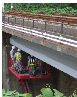
図2 塩化物イオン吸着材を用いた補修箇所 (A 橋りょう)
