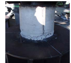
(c) 充填コンクリートのひび割れ・圧壊
