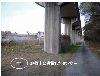
図4 地震計の設置状況
