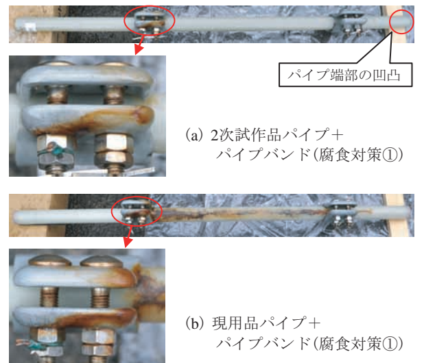
図8 課電暴露試験における2次試作品パイプとパイプバンド（腐食対策①）の外観（暴露期間17ヶ月）
