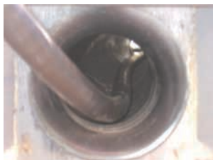
図21 ヌルフラックスケーブル敷設状況
