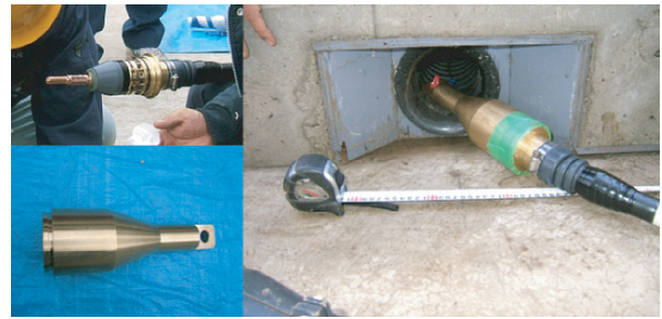
図22 端子部保護カバーと使用状況
