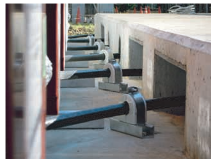
(c)ヌルフラックス線床面固定
