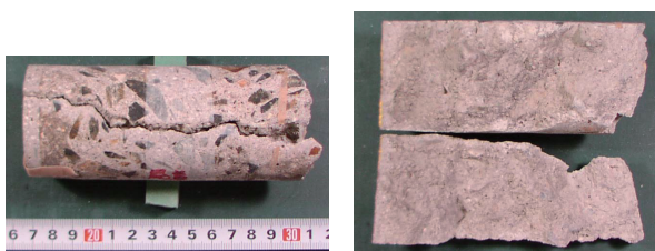
図10 コアボーリングにより採取したひび割れ面
