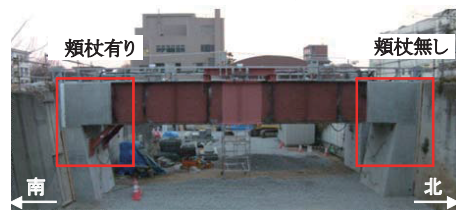
(b) 一体化補強後
