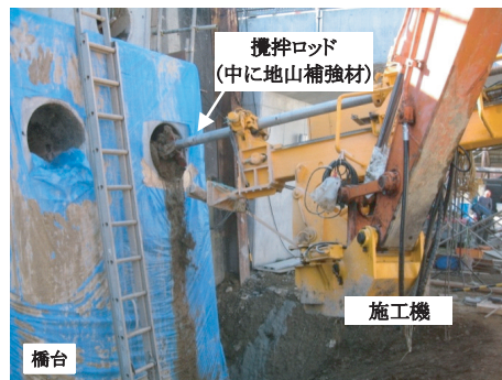
図5 地山補強材の施工状況
