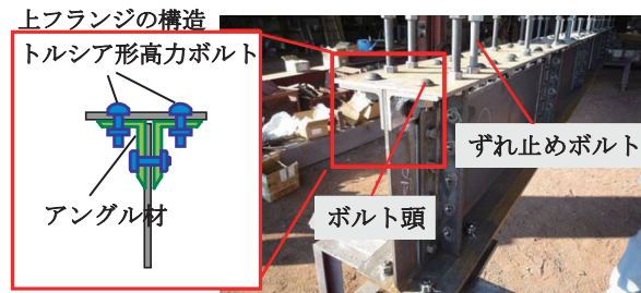
図5 試験体（鋼桁）の上フランジの状況
