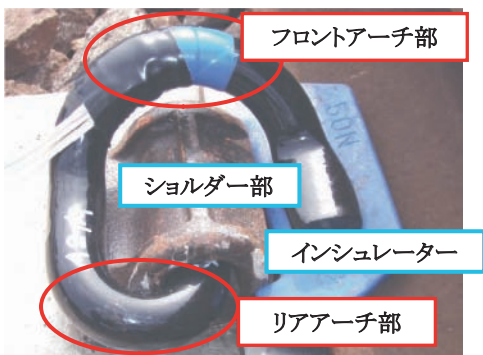
図1 線ばねクリップの例（SST形）
