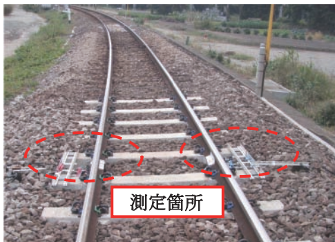
図7 現地試験の実施概況 (A1断面)
