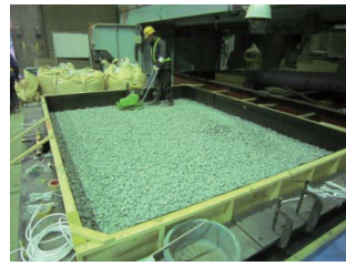
図9 碎石の締め固め
