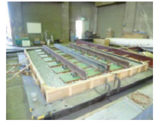
図10 軌きょうの設置
