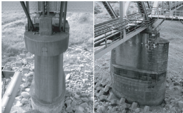
(a)上り線橋脚 (b)下り線橋脚 図6 測定対象橋脚
