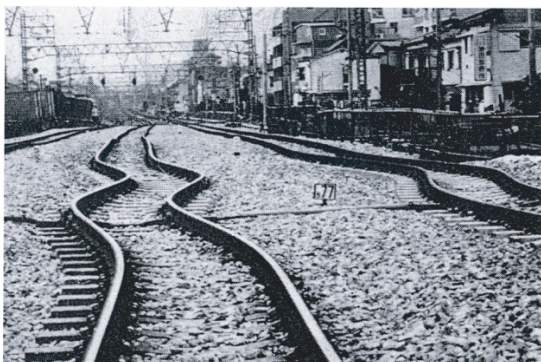
図1 地震を受けた軌道の変状の例
