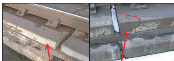
図4 軌道スラブの補修状況
