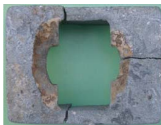
図8 引抜破壊試験で破壊したアンカープレート
