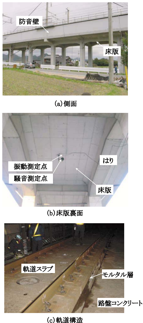
図1 対象としたコンクリート高架橋の外観
