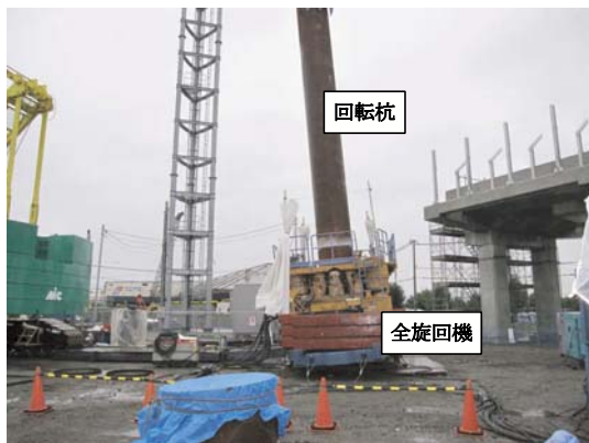
図5 回転杭（斜杭施工）
