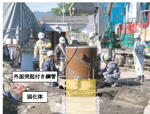
図4 鋼管ソイルセメント杭
