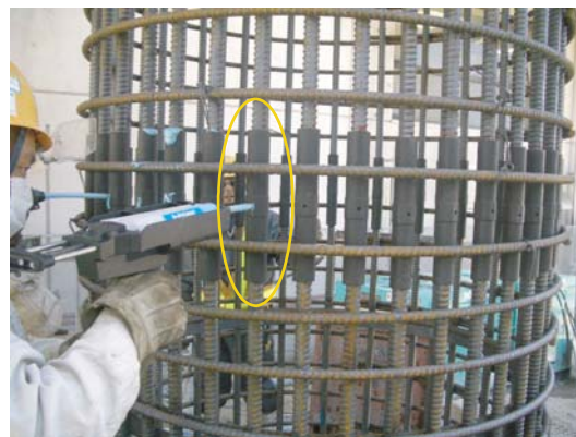
図3 機械式鉄筋継手の例
