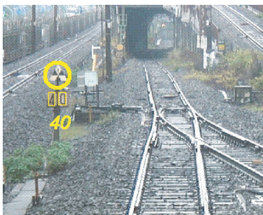
図9 徐行予告信号機および速度標識の画像認識
