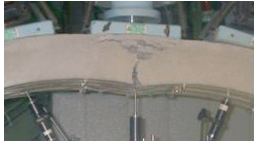
図10 Case6の供試体破壊状況(天端部)
