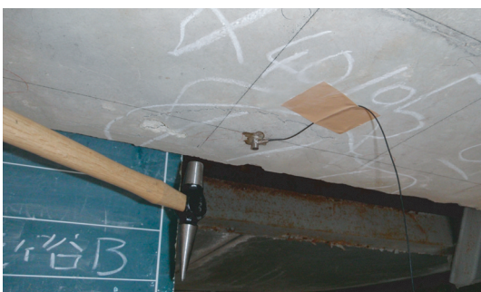
図 14 不健全箇所でのコンクリート表面加振試験の様子
