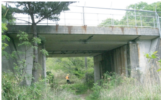
図 13 検証試験で実施した新幹線橋梁
