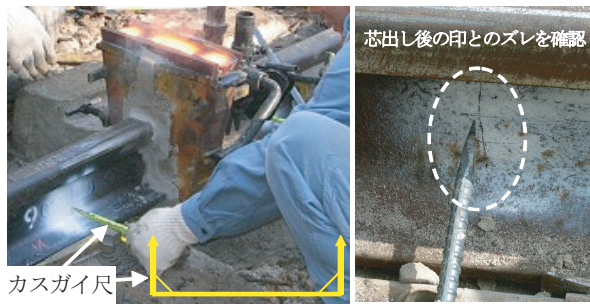
(a) レール移動の確認 (b) 印付け位置 図5 カスガイ尺によるレール移動の確認状況
