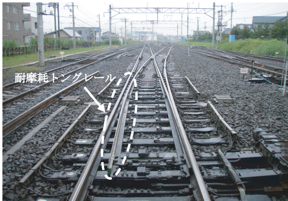
図10 試験敷設の状況
