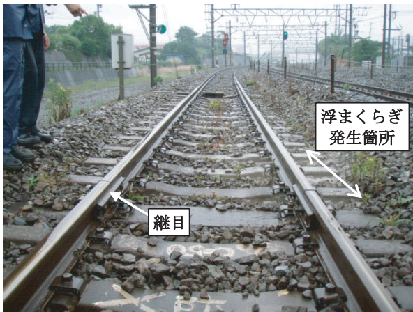
図12 施工箇所の状況（起点方）
