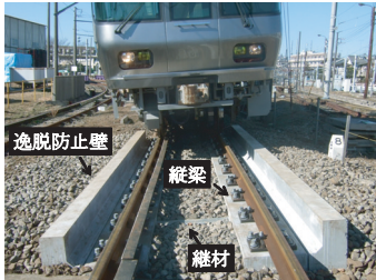
図17 逸脱防止構造を設けたバラスト・ラダー軌道の試験敷設状況
