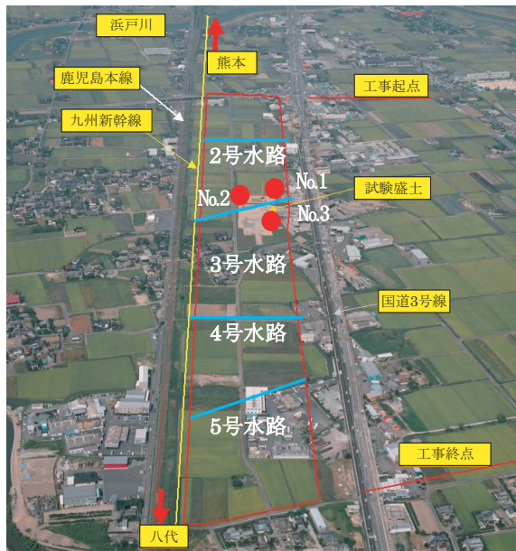
図9 熊本車両基地の全景
