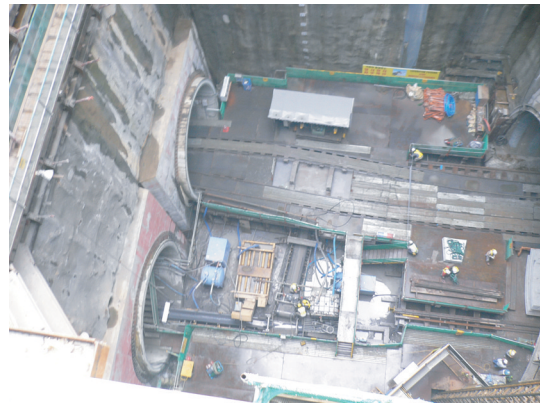
図4 トンネル建設現場
