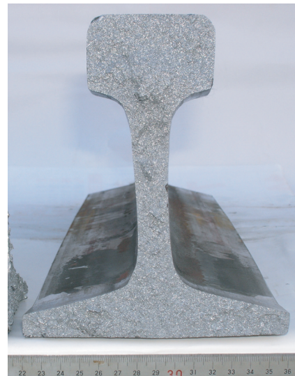
図7 試験継手の破断面状況 (TPNo. E-3)
