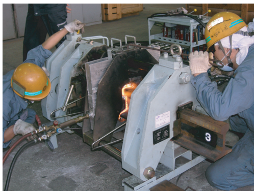
図3 試験継手作製作業状況
