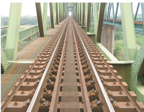
木曾川橋梁 東海道本線（木曾川・岐阜間）
