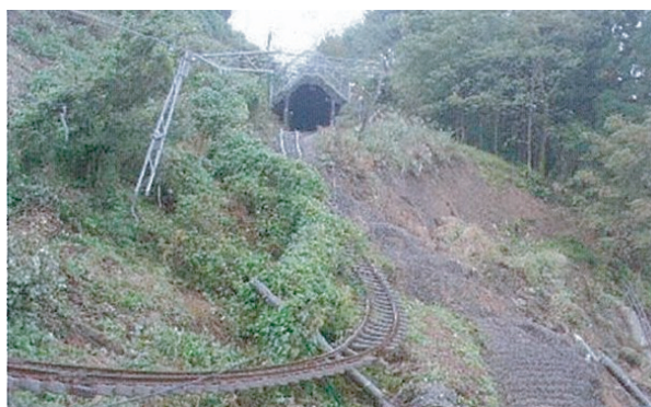
図1 2004年新潟県中越地震における鉄道盛土の被災事例(JR上越線220k300m)
