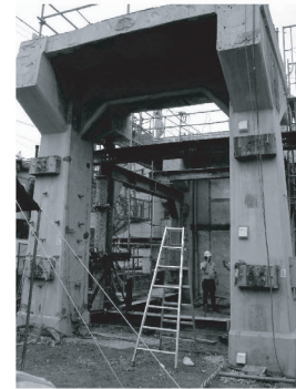
図6 ラーメン高架橋単独柱の載荷試験状況
