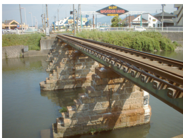
図1 石積み単体で構築された橋脚
