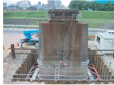
図5 木杭基礎橋脚載荷試験状況
