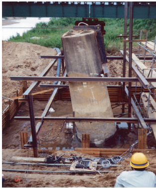
図3 直接基礎載荷試験状況
