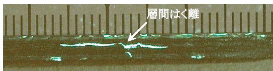
図17 欠陥検出部の浸透探傷結果
