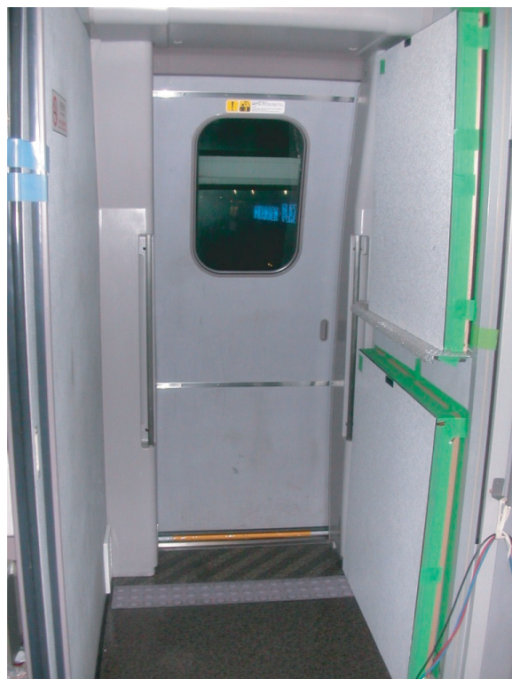
図7 デッキ部外妻への騒音低減パネルの取付け状況
