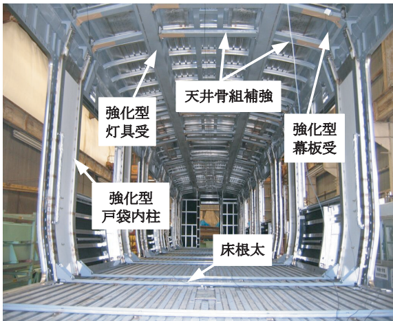
(b) 車内の補剛部材取り付け状況
