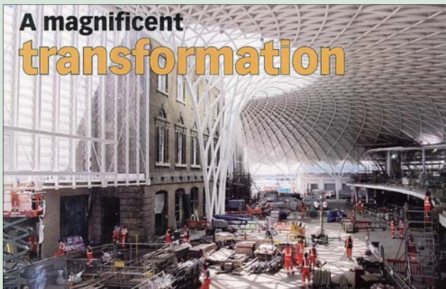
図1 改築の中心的構造物である長大スパンの屋根と漏斗状の支柱
