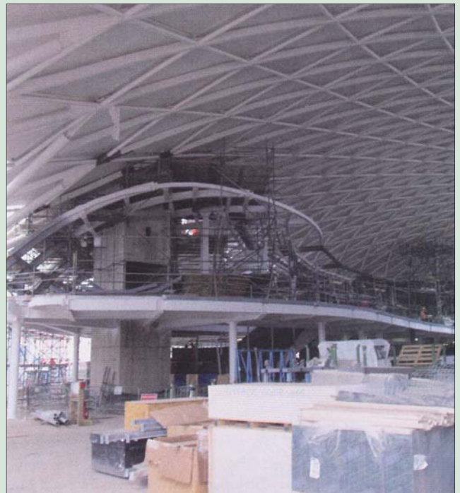
図2 S字状に湾曲した屋根を支える円柱
