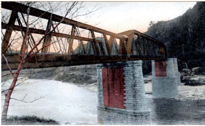
白石の設計により1897(明治30)年に完成した関西鉄道木津川橋梁(側径間の2連はランガー補強ののち現用中)
