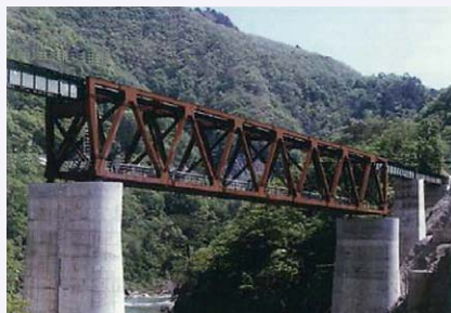
図8 無塗装鋼鉄道橋(第三大川橋梁) 出典:語り継ぐ鉄橋の技術 (鹿島出版会発行,楳横河ブリッジ所蔵)
