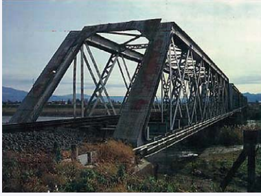
図2 明治時代からの代表的な鉄橋 (最上川橋梁 1886年製作)
