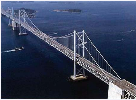
図10 吊橋(南備讃瀬戸大橋(手前)と北備讃瀬戸大橋) 出典：語り継ぐ鉄橋の技術 (鹿島出版会発行、旧本州四国連絡橋公団所蔵)
