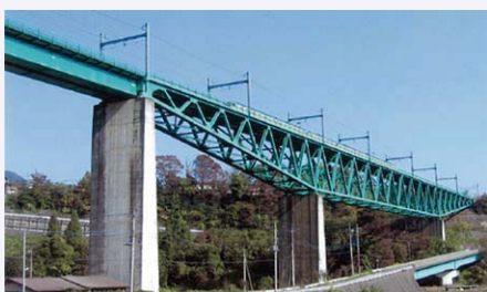
図6 景観を重視した上路トラス橋 (新桂川橋梁)(提供:中野昭郎氏)
