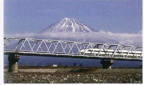
図4 下路トラス(富士川橋梁) 出典:語り継ぐ鉄橋の技術 (鹿島出版会発行, 阿部英彦氏所蔵)
