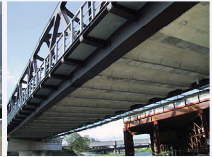
図12 SRC床版を有する下路トラス橋 (鴨川橋梁) (提供：JR西日本)
