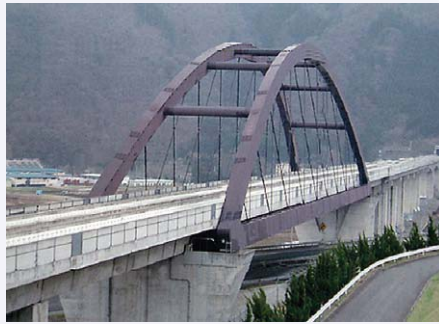
図11 ニールセンローゼ型アーチ橋 (小形山橋梁)
