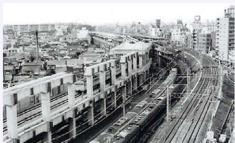
図7 鉄骨鉄筋コンクリート構造 (赤羽高架)(提供:中野昭郎氏)
