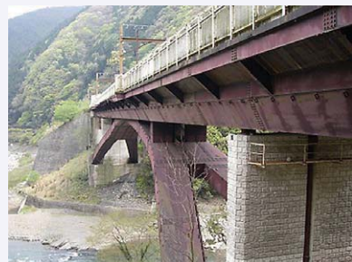
図9 無塗装鋼鉄道橋 (第2保津川橋梁)(筆者撮影)
