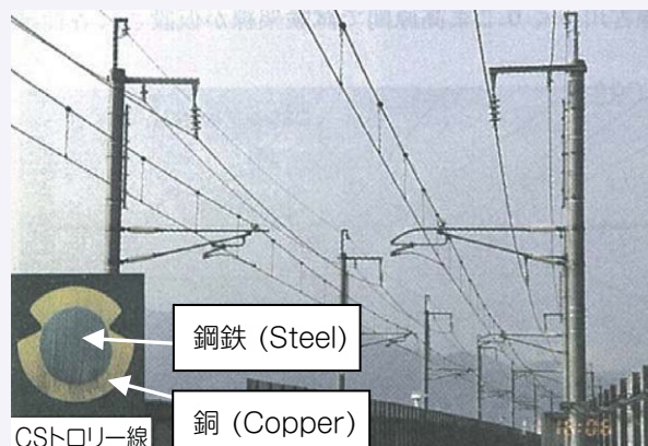
図7 CSトロリー線とCSシンプルの例
