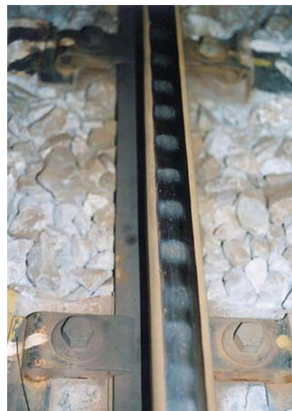
図3 急曲線内軌波状摩耗の例
