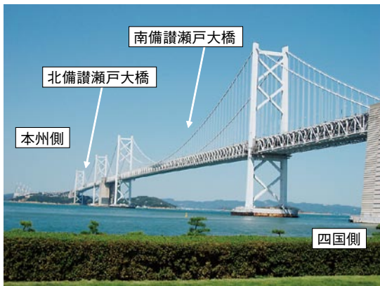
図1 本四架橋、瀬戸大橋の鉄道吊橋
