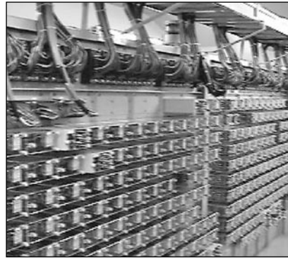
図2 継電連動装置の外観
