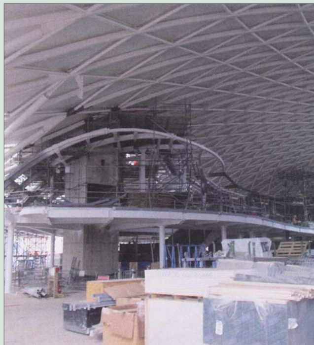
図2 S字状に湾曲した屋根を支える円柱
